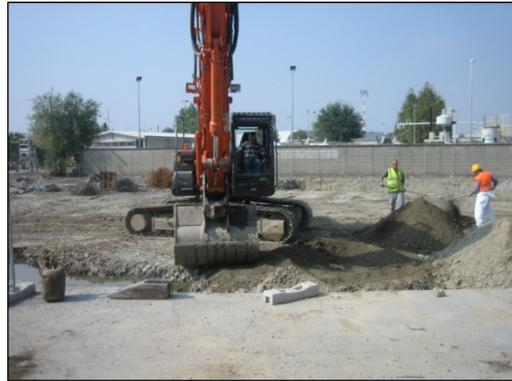
La metodica utilizzata è la combinazione delle due tecniche ovvero è stato eseguito prima una irrorazione con la soluzione al 10% di MPCD Skipper Petrol 95 alle medesime condizioni utilizzate in precedenza e dopo qualche ora è stata fatta la miscelazione con il compost: 20 – 25 % di materiale/m<sup>3</sup>
