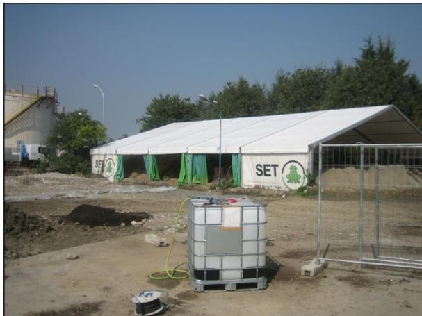
Da evidenziare che il piano idrogeologico presenta una falda molto alta (guardando la foto qui sopra, si pensi che al di là degli alberi si trova l'idroscalo), quindi ad un limite stabilito intorno a circa 5 metri è diventato impossibile scavare e bonificare, in quanto si sarebbero corsi rischi oggettivamente non quantificabili: di fatto una parte di terreno contaminato non è stato possibile estrarlo e trattarlo (\*).
